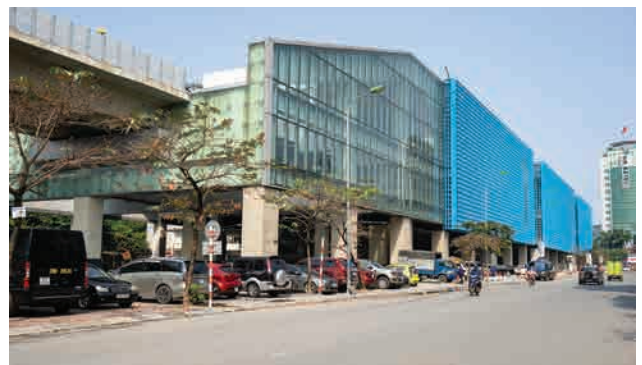
Cat Linh - Ha Dong Train Station, Ha Noi
