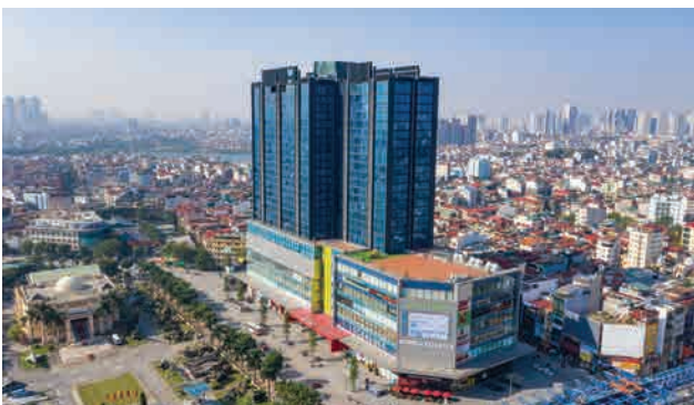
Artemis Tower, Le Trong Tan Str., Hanoi City
